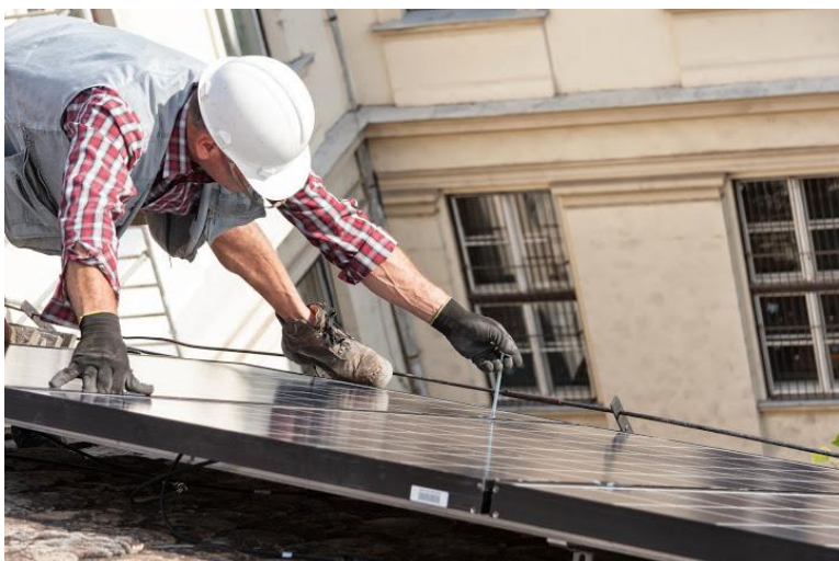
Panelek rögzítése csavarozással
