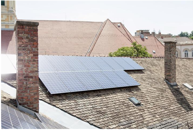
Panelek a tetőn
